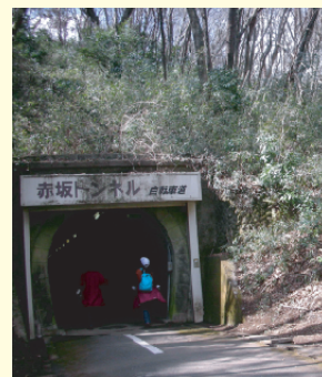
赤坂トンネル
